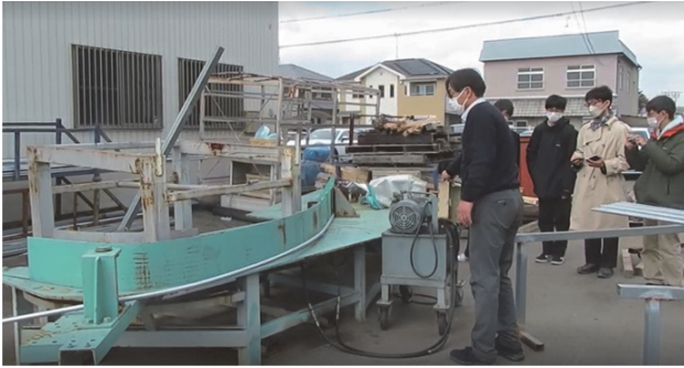
図2. アーチパイプ製作現場の見学
