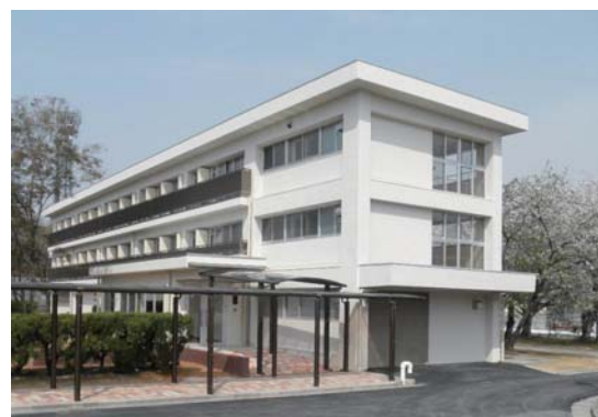
斑鳩寮 Ikaruga Dormitory
