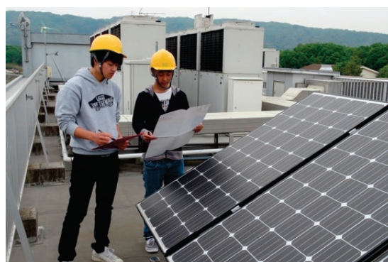
太陽電池 Solar Batteries
