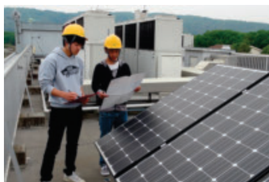
太陽電池 Solar Batteries
