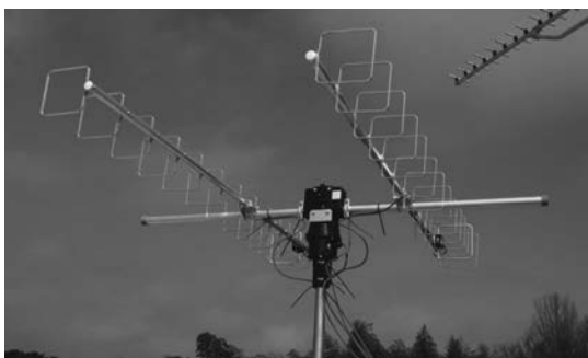
図10 設置と調整が完了したアンテナ
