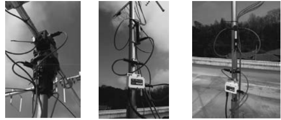
図11 ケーブルの取り付けと引き回し
