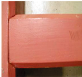
図2 寺院での門扉の例材の塗装除去を行った。
