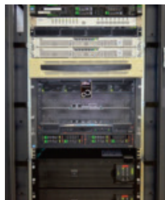
サーバ室 Computer Server Room
